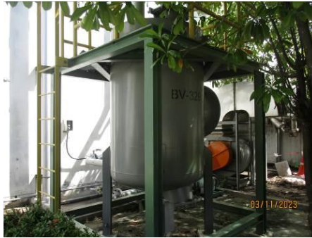
ภาพที่ 2-25 ระบบ Carborn Absorber
